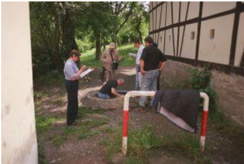
Einstieg in einen Schacht mit 8 Meter Tiefe
